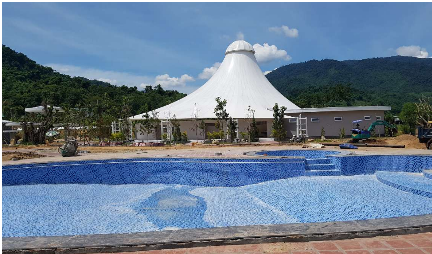
| Công Trình Xây Dựng Hồ Bơi Yang Bay
