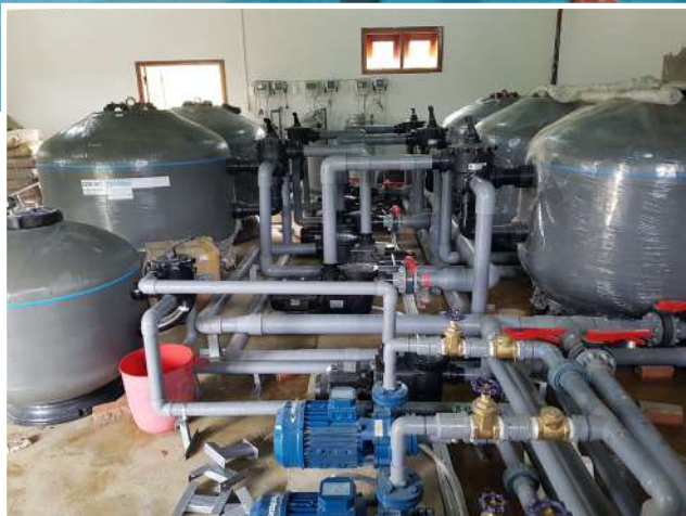
| Trang Thiết Bị Lọc Nước Bể Bơi Yangbay
