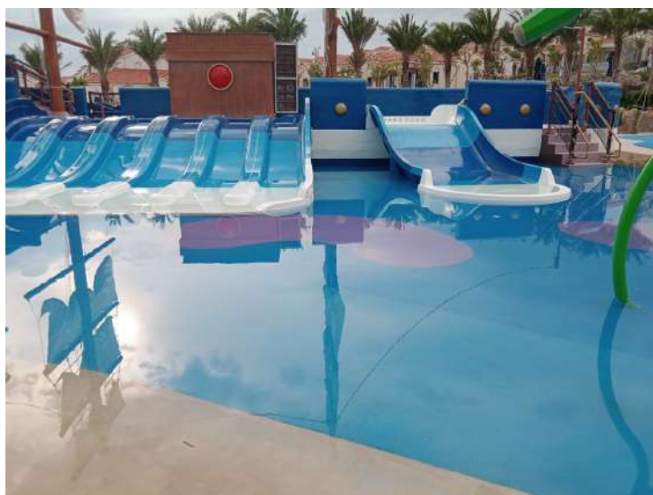
Sân Chơi WaterPark - Sàn EPDM nước - Nova Hill |
